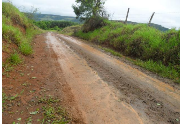
Estrada AGT-250/ trecho B1- final
