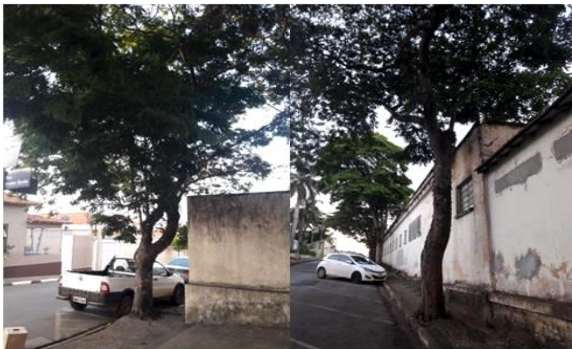
Foto 1. Afloramento de raiz da árvore sibipiruna ( Cenostigma pluviosum (DC.) E. Gagnon & G.P. Lewis), em calçada de 1 metro de largura, no centro da cidade de Angatuba, 2019.
