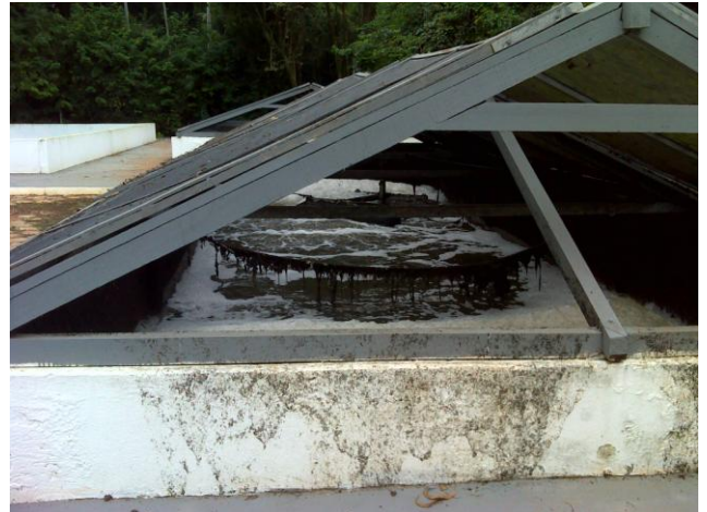
FOTO 4.38: TANQUES AERADOS
