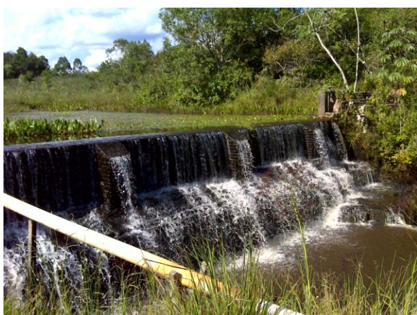
FOTO 4.1 CAPTAÇÃO, POR GRAVIDADE, NO RIBEIRÃO DA CACHOEIRA
