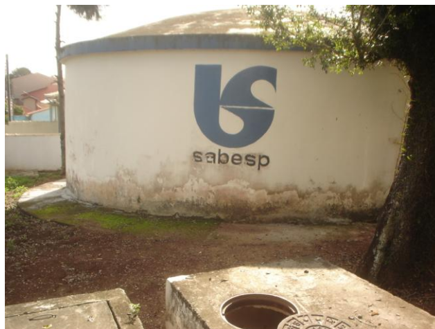
FOTO 4.15 - RESERVATÓRIO JARDIM NERY
