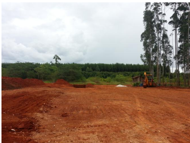
FOTO 4.43 - ATERRO SANITÁRIO – VALAS
