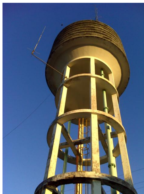
FOTO 4.13 - RESERVATÓRIO SEDE 2 (DESATIVADO)
