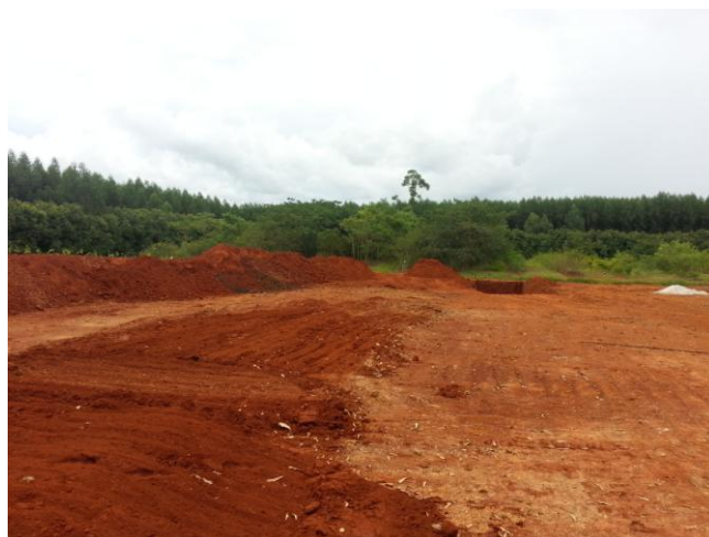
FOTO 4.44 - ATERRO SANITÁRIO - VALAS
