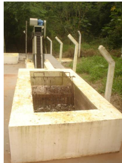
FOTO 4.36: GRADEAMENTO MANUAL E MECÂNICO
