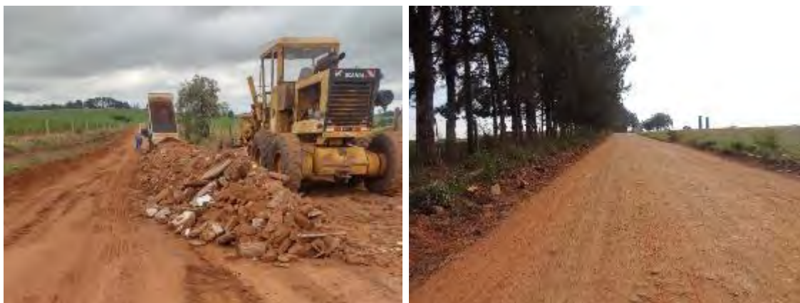
Foto 15 – Uso de RCC segregado em manutenção de estradas, em Manduri.
