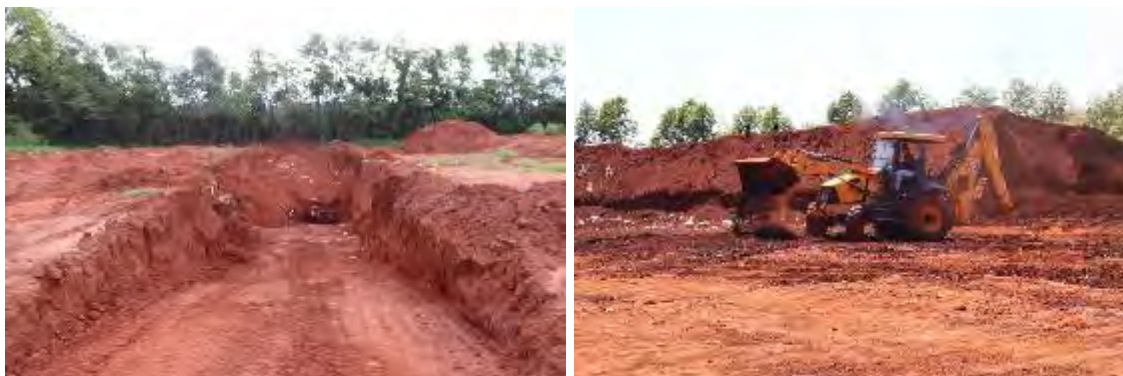
Foto 3 - Aterro Sanitário de Barão de Antonina e Itai.
